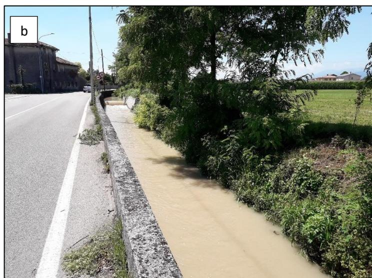
Figura 6 Immagine scarico Balbi: a) stato di fatto della roggia Balbi e b) piena della roggia Balbi con attivazione dello sfioro a monte del nodo idraulico
