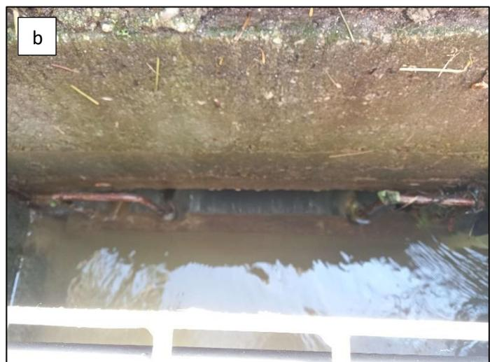
*Figura 10 Punto di diramazione della Roggia Balbi: a) dettaglio della deviazione dell'acqua per mezzo della paratoia abbassata; b) dettaglio dello sfioro sopra la paratoia*
