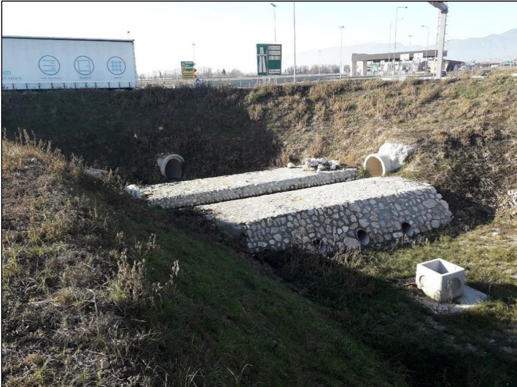
Figura 23 Nodo idraulico in via San Zenone: nodo di conguaglio delle acque nei pressi della rotonda in via San Zenone.
