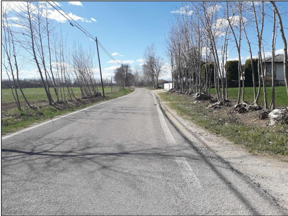
*Figura 11 Esempio di abbassamento del piano campagna stradale rispetto al piano dei campi a causa dell'intensa attività agricola (dettaglio di via Po (Ramon))*
