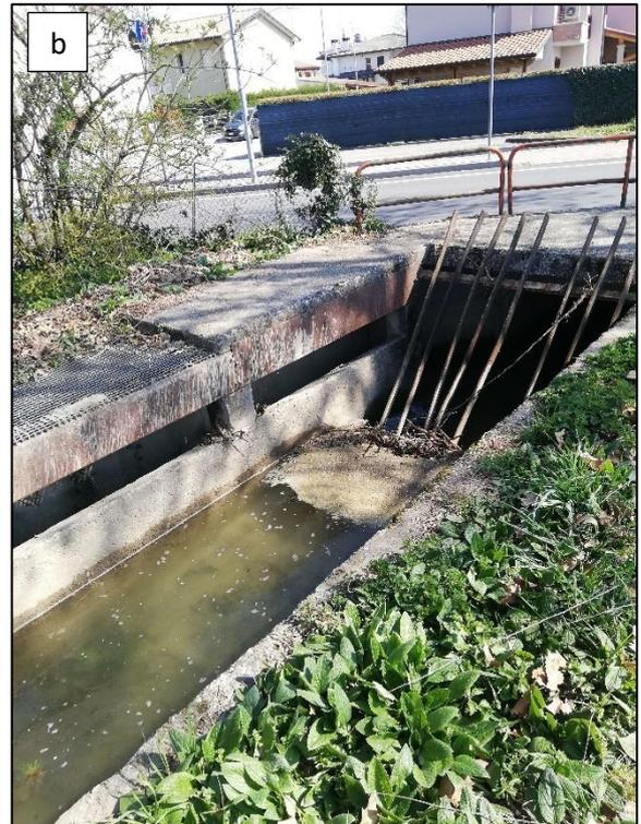
Figura 13 Immagini tratte dal Volone: a) nodo idraulico del Volone lungo via Crosera in cui è presente una griglia e uno sfioratore laterale; b) dettaglio del nodo idraulico
