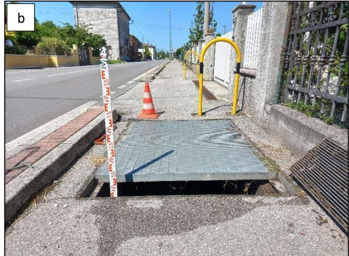
*Figura 9 Punto di diramazione della Roggia Balbi: a) ramo principale in cui il corso d'acqua torna a cielo aperto; b) nodo idraulico tra il ramo principale e lo scarico*
