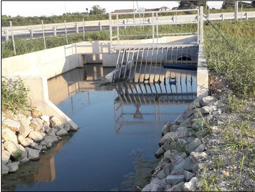
*Figura 21 Nodo idraulico in via San Zenone: si nota la presenza di uno scolmatore, una griglia di trattenuta del materiale solido e un bypass stradale*
